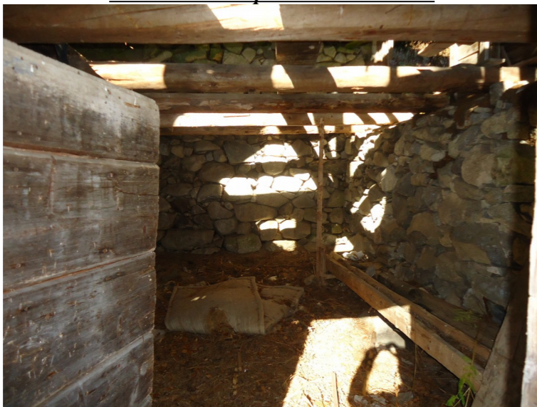
Vista interna della stalla
