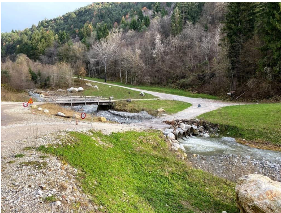
Fig. 2.9: vista sul secondo tratto d'intervento in corrispondenza del guado. Si prevede di spostare il nuovo guado più a monte di quello esistente; demolendo il guado esistente si dà la possibilità al corso d'acqua di riprofilare l'alveo aumentando di fatto la pendenza subito a monte della briglia posta immediatamente a valle (vedasi relazione idraulica). La contestuale rimozione del ponte in legno esistente va quindi a ripristinare la totalità della larghezza utile dell'alveo.
