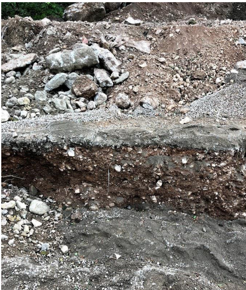
Fig. 2.13: scavo eseguito in corrispondenza del secondo intervento a progetto, per la messa in opera delle tubazioni della centralina idroelettrica posta in corrispondenza del terzo tratto. Dall'immagine si osservano i depositi alluvionali e/o fluvioglaciali grossolani: formati da ghiaia poligenica (granitica, calcareo dolomitica, metamorfica) da spigolosa a subarrotondata, con ciottoli e blocchi di granito ( \varnothing 70÷80 cm), in matrice sabbiosa limosa di colore grigio, mediamente addensata.
