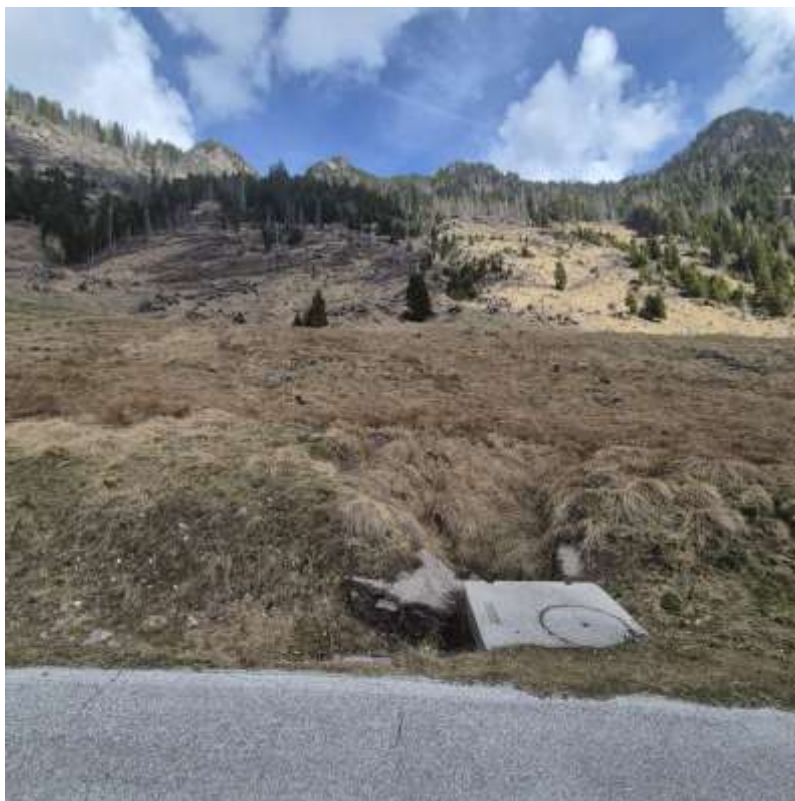
Fig. 4 – Pozzetto d'ispezione in calcestruzzo con chiusino a bordo della strada silvo-pastorale: punto di recapito attuale delle acque di deflusso.
