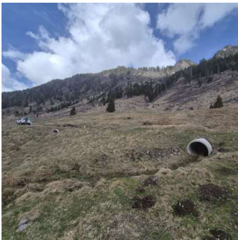
Fig. 5 – Elementi tubolari in calcestruzzo presenti nella porzione centrale del prato e tracciato dell'impluvio esistente.
